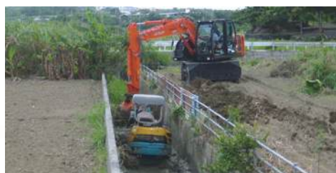
水路の土砂上げ作業
